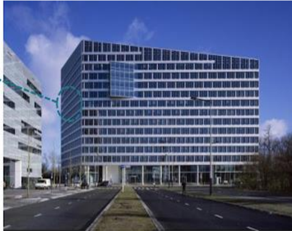
شكل ( ٦ ) زجاج البلورات السائلة السميك الذي يدعم الحماية من أشعة الشمس عند الحاجة بمبنى The Edge (١٨)
