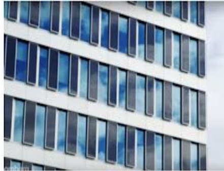
صورة (١٥) تظليل الواجهة الجنوبية بالألواح الشمسية والنوافذ المنظمة للحرارة والظل بالمبنى (١٨)
