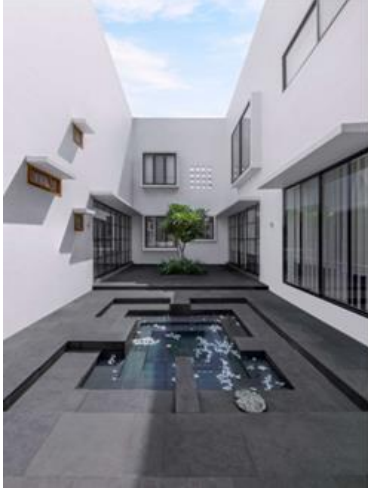
صورة (٥) وجود نوافذ كبيرة بمنطقة الاستقبال بالدور الأرضي تسمح بمرور جيد للتيارات الهوائية الباردة لداخل الفراغات الداخلية، ووجود كاسرات الشمس فوقها.
