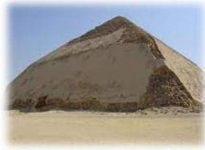
شكل رقم (٨) يوضح كسوة الأهرام بالحجر الجيري لعكس اشعة الشمس – الهرم المنكسر
