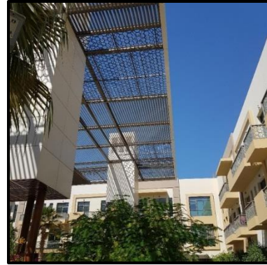
شكل رقم (٢٧) تظليل مواقف السيارات بألواح الطاقة الشمسية شكل رقم (٢٦) أسقف خشبية مفرغة لتوفير الظلال والتهوية الطبيعية
