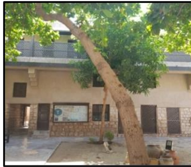
شكل رقم (١٠) الفناء الداخلي المكشوف - حي البستكية - دبي
