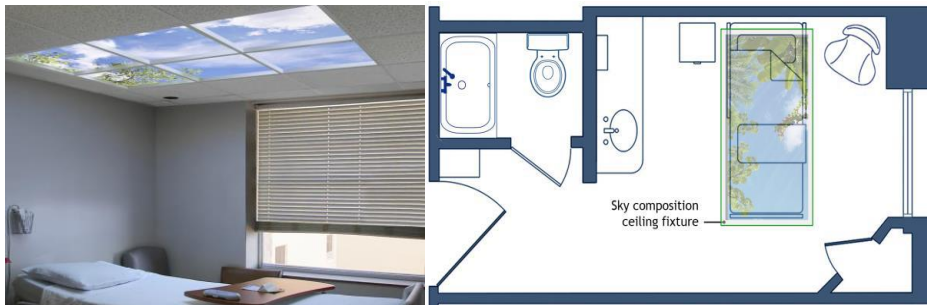
صورة ١٥ – صورة ١٦ استخدام أسقف السماء الافتراضية أعلى الأسرة بمستشفى كورنيل هيلث في لوبوك، بتكساس
