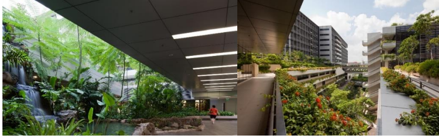
صورة ١٧ – صورة ١٨ مستشفى خوتك بو بسنغافورة، يتضح من خلالها التصميم المعماري المرتبط بالبيئة للفراغات الخارجية والداخلية. (RMJM 2017)
