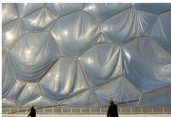
شكل (١٨) شكل الوسائد بعد التركيب وأثناء نفخها بالهواء
