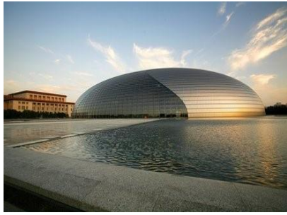
صوره رقم: ٢٤ توضح تناغم خطوط التصميم للمبني مع العنصر المائي وتداخله وإطلاله عليه من ناحيتين نقلًا عن: https://ar.advisor.travel
