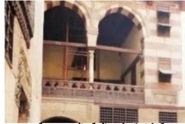
صورة ٤٩ توضح العقد المدبب بمقعد بيت السحيمي (المصدر: الباحث)
