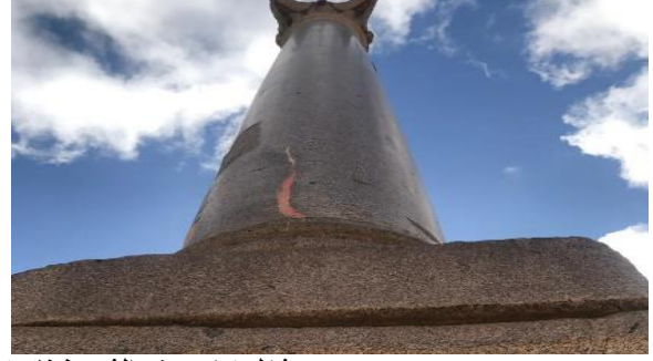
شكل ١٤ : بعض الشروخ ناتجة عن التآكل نتيجة الفحص البصري
