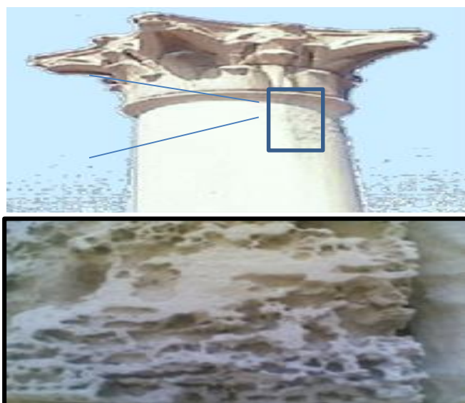
شكل ١١ : لأنفاق السنخية بسبب تبلور الأملاح واذابة مكونات الأحجار
