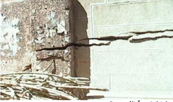
شكل ١٤ : بعض الشروخ ناتجة عن التآكل نتيجة الفحص البصري
