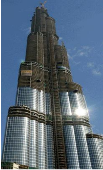
شكل (6) صورة توضح واجهة البرج المكونه من الحوائط الستانية الزجاجية أثناء تركيبها ، والمكونه من طبقتين من الزجاج المطلي بطبقة من الفضة الخالصة لعكس أشعة الشمس وبذلك يتم تقليل الاشعاع الحراري المتسرب الى المبنى من خلال زجاج الواجهات. المصدر (٥)
