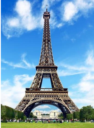
شكل (3) يوضح برج إيفل في باريس والذي يعد أول بناء حديدي مرتفع وأول نموذجاً لناطحة السحاب من الحديد، وقد تم بناؤه أثناء عصر الثورة الصناعية ، ويعد من الطفرات التي حدثت للمباني البرجية ولإنشاء بأسلوب سبق التصنيع وهو ما فتح الباب لناطحات السحاب بشكلها المتعارف عليه اليوم. المصدر (٤)
