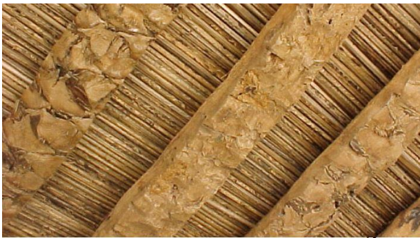
صورة (١٠) توضح كيفية استخدام جذوع النخيل في عملية التسقيف ١٠
