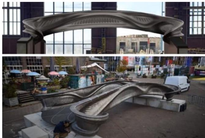
شكل رقم (٢٥) يوضح تنفيذ أحد الكباري بواسطة CNC مستخدما الحديد كخامة تشكيل
