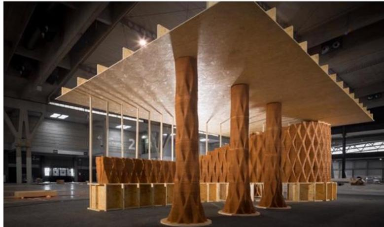
شكل رقم (٢٨) يوضح تنفيذ أحد التكوينات البنائية بواسطة CNC مستخدما طباعة الطينة
