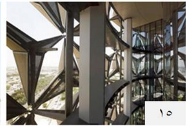
صورة (١٥، ١٦، ١٧) الغلاف الخارجي للمبني ومحاكاة فكر العمارة الاسلامية كاستحداث لتصميم المشربية للتحكم في درجة الحرارة وكمية الضوء النافذ- المصدر: architectes-dz.blogspot.com/2016/12/al-bahar-towers.html
