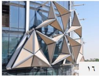
صورة (١٥، ١٦، ١٧) الغلاف الخارجي للمبني ومحاكاة فكر العمارة الاسلامية كاستحداث لتصميم المشربية للتحكم في درجة الحرارة وكمية الضوء النافذ- المصدر: architectes-dz.blogspot.com/2016/12/al-bahar-towers.html
