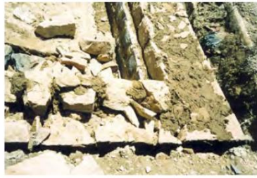
صورة رقم (٦) يتكون الجدار في العمارة التقليدية من صفيين الاحجار بينهما رابط مما ساعد على زيادة سمك الجدار وانعكس كذلك على تأخير وصول الحرارة للفراغات الداخلية
