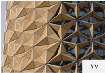
صورة (١٥، ١٦، ١٧) الغلاف الخارجي للمبني ومحاكاة فكر العمارة الاسلامية كاستحداث لتصميم المشربية للتحكم في درجة الحرارة وكمية الضوء النافذ- المصدر: architectes-dz.blogspot.com/2016/12/al-bahar-towers.html
