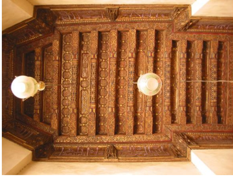
الصور (١٣) : توضح السقف الخشبي والشريط الكتابي بالدركاه المصدر : تصوير الباحثة
