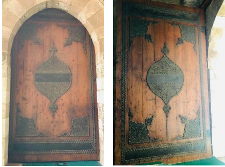
الصورة (٧) و(٨) : توضح العقود المدببة ذات المركزين بباب الدهليز والمدفن المصدر : تصوير الباحثة
