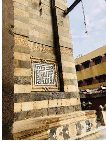
الصورة (١) : توضح المكسلة بالمدخل المصدر: تصوير الباحثة
