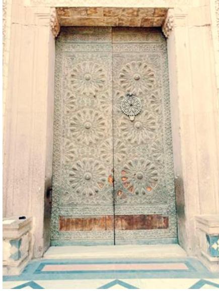
الصورة (٢) : توضح باب المدخل المصدر: تصوير الباحثة
