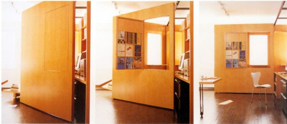
شكل رقم (13) يوضح إستخدام مبدأ الدمج من خلال تحويل الفراغ من فراغ للمعيشة إلى فراغ مكتبي و ذلك يوضح المراحل المختلفة لطبي و تشغيل الفاصل الخشبي الذي يعمل على ، ونلاحظ أن حركة الفاصل تتم عن طريق مجرى معدنية مثبتة في السقف
