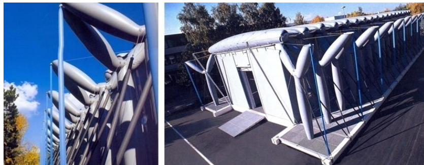
شكل رقم (15) مبنى قابل للنفخ من تصميم شركة " Festo الألمانية ، ونرى الأعمدة التي تتخذ شكل " Y حيث تدعم المبنى و كذلك الكمرات الضخمة التي تعمل على تدعيم سقف المبنى. نقلا عن www.festo.com
