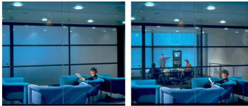
شكل رقم (17) يوضح استخدام مبدأ تغيير اللون و الشفافية في القواطع الزجاجية الداخلية، حيث نرى قدرتها على حجب الأنشطة المتنوعة.
