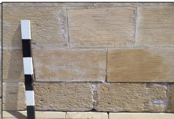
صورة (٤٤) توضح الأحجار بعد تطبيق المادة العازلة عليها
