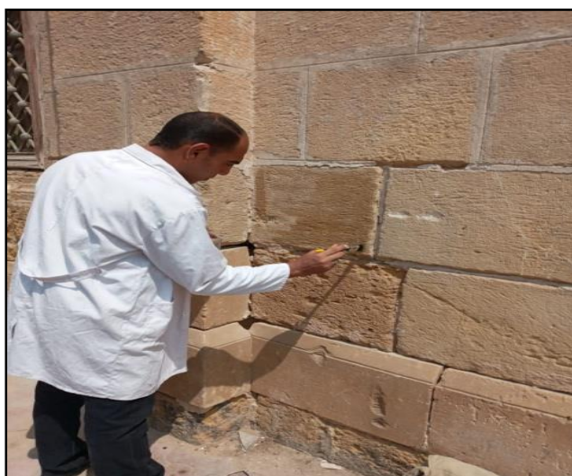
صورة (٤٣) توضح تطبيق المادة العازلة على سطح الأحجار باستخدام الفرشاة ولم تظهر أى تغيرات لونية للأحجار
