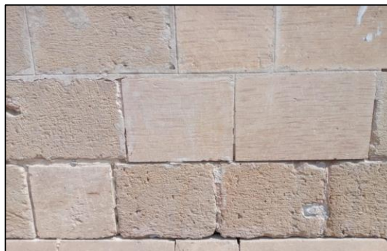
صورة (٣٤) توضح الأحجار بعد التنظيف بالطرق الميكانيكية
