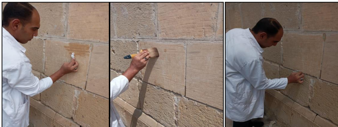
صورة (٣٤) توضح إزالة الأتربة الموجودة على سطح الأحجار بالطرق الميكانيكية باستخدام الفرش الناعمة
