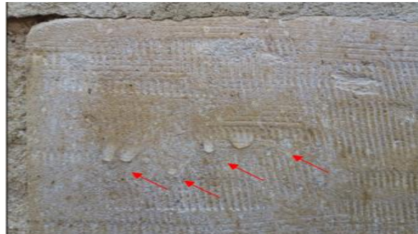
صورة (٤٦) توضح عدم امتصاص الأحجار المعالجة للماء واستمرار قطرات المياه عليها
