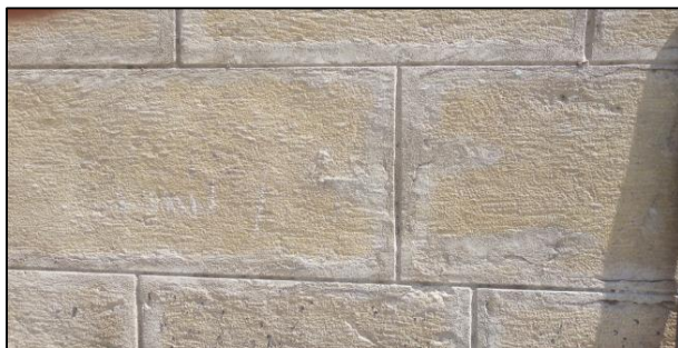
صورة (٣١) توضح وجود التكدسات والإرساخات على سطح الأحجار صورة (٣٢) توضح وجود التكدسات والإرساخات على سطح الأحجار
