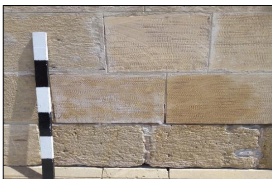
صورة (٣٥) توضح الأحجار بعد التنظيف بالطرق الكيميائية
