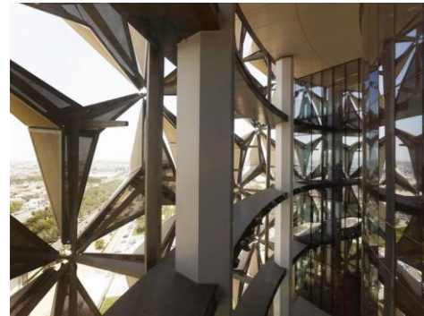
صورة (٣) توضح مبنى البحار بأبو ظبي الامارات توضح تحقيق الحركة الديناميكية بالفراغات الداخلية من خلال وحدات ديناميكية مستخدمة في الواجهة مستوحاة من فكرة المشربية تتبع حركة الشمس فتحدث حركة بالفراغات الداخلية.
